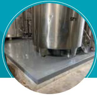
Rivestimento bacini di contenimento
